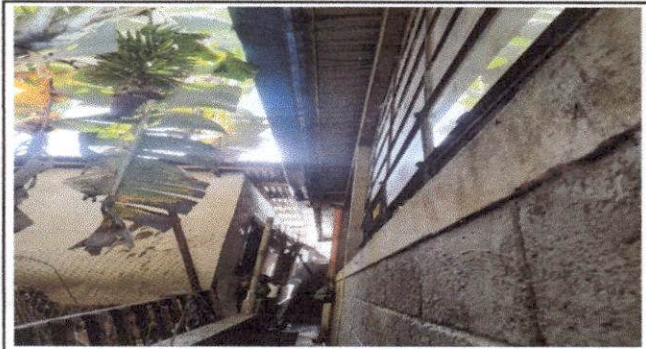
Foto 2: Canales de bajada de agua.
